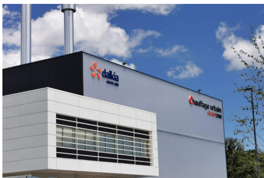
2019 - Chaufferie Surville - Akyver® Paneltherm Anti éblouissement
