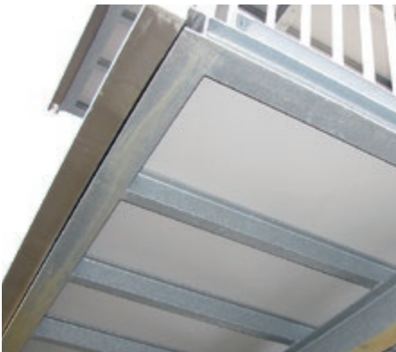
SOUS-CONSTRUCTION / PARTIE PORTEUSE
