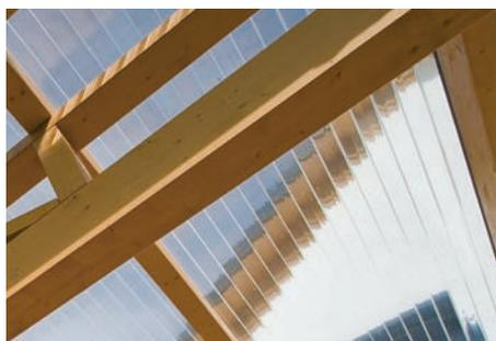
Avec le revêtement NO-DROP sur une face, l'eau de condensation sur les plaques s'écoule sous forme de film empêchant la formation et la chute de gouttes en enlevant plus facilement les saletés et feuilles.
