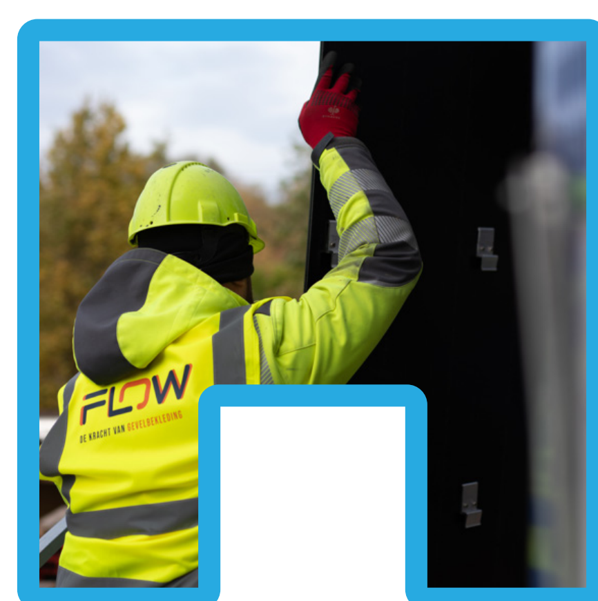
Démonter les anciens panneaux Trespa
